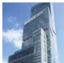
あべのハルカス JR 線・地下鉄各線 天王寺駅、近鉄線大阪阿部野橋駅直結 “阿倍野 Harukas” 与 JR 线・地铁各条线路的天王寺站，近铁线的大阪阿倍野桥站相连接
