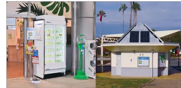
太陽光発電から冷蔵内蔵型ショーケース へ直接給電
