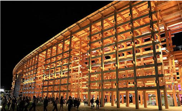
万博会場に建設された大屋根リングの様子
