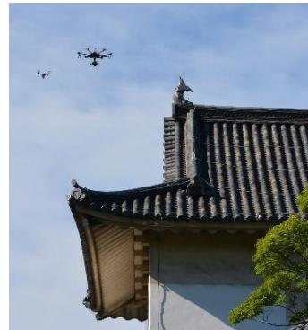
② 概要：高解像度カメラを搭載したドローンで、「大阪城・六番櫓」の屋根上部や堀側南壁面を画像撮影し、瓦のズレや破損、壁面の割れや浮きなどの状況を確認する。
