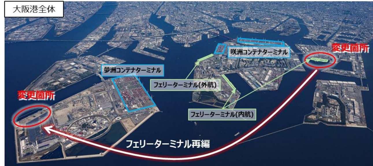
大阪南港フェリーターミナルの現状
