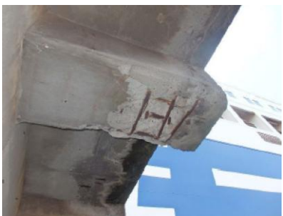
コンクリート剥離・鉄筋露出
