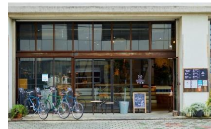
通りに賑わいと交流を感じさせる1階店舗 「Nui. HOSTEL & BAR LOUNGE」 出典： https://dolive.media/266/
