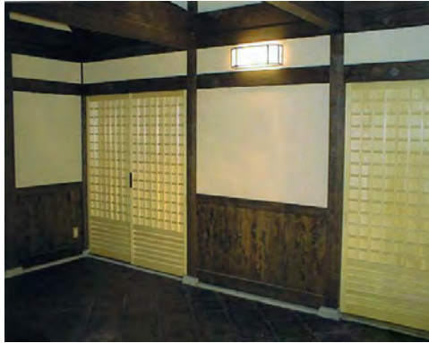
同社施工の全興寺の建具
