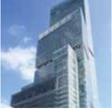
あべのハルカス JR 線・地下鉄各線 天王寺駅、近鉄線大阪阿部野橋駅直結 “阿倍野 Harukas” 与 JR 线・地铁各条线路的天王寺站，近铁线的大阪阿倍野桥站相连接
