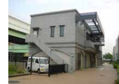
水門通過者の目に触れる機会が多い管理棟。景観の魅力アップが望まれる。
